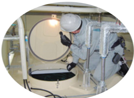
受水槽の検査
