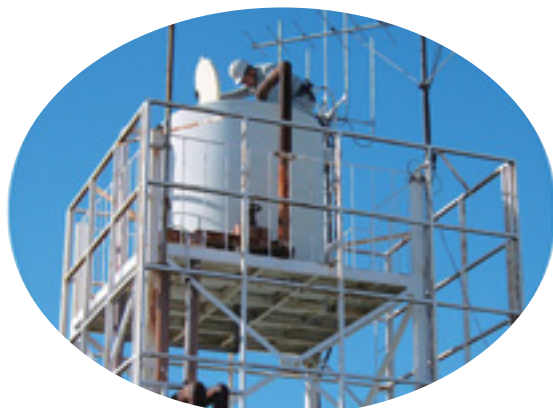
高置水槽の検査
